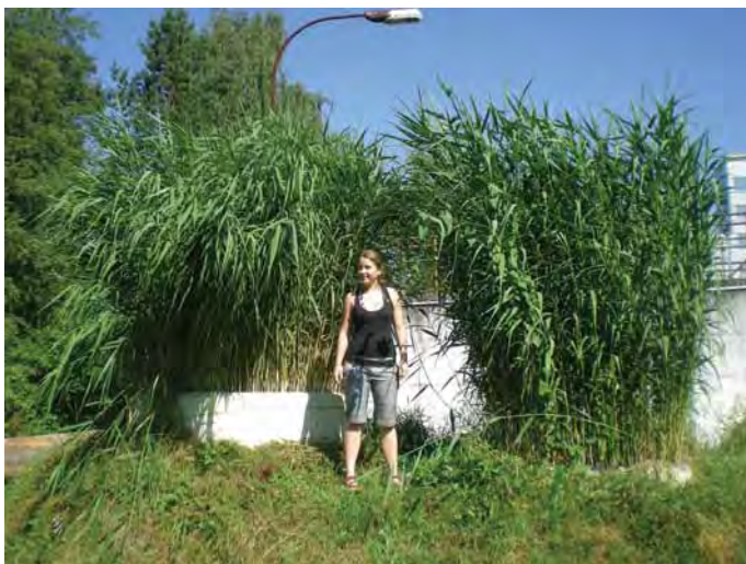
Obr. 2. Vodou saturovaný (anaerobní) vertikální mokřad (vlevo) a volně průtočný (aerobní) vertikální mokřad (vpravo)
