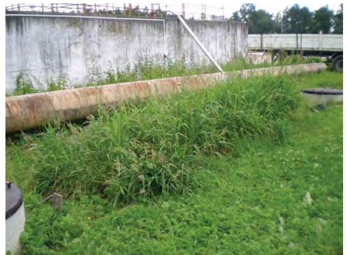
Obr. 3. Horizontálně protékající umělý mokřad, tj. klasická kořenová čistírna
